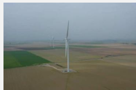
Parc de CHAMPS PERDUS Département : Somme (80) Puissance électrique : 12 MW 4 éoliennes Mise en service : 2014
